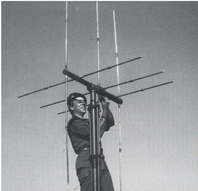
**Montage des dipôles sur antenne Yagi
